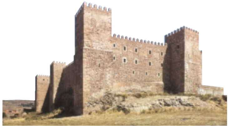
Aspilleras en la fachada de una fortificación.
