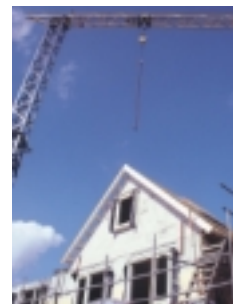
Edificación de un chalet.
