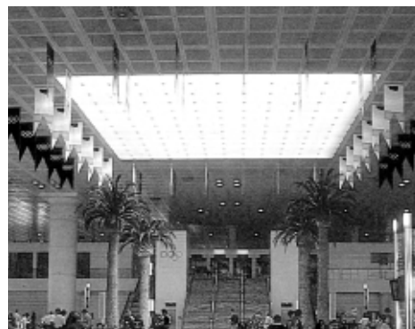
Claraboya en el techo de un edificio.
