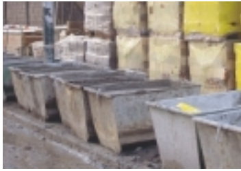
Contenedores utilizados como escombreras.
