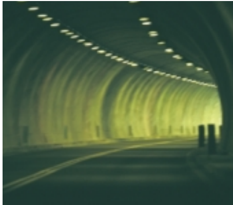
Resplandor al final de un túnel de carretera.
