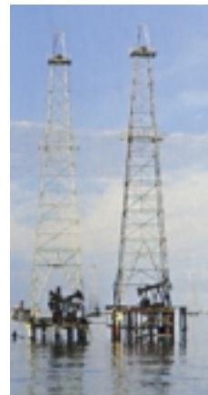
Torres extractoras de petróleo en el lago Maracaibo.
