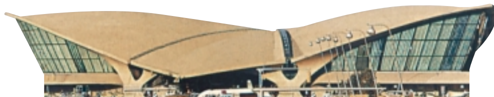
Estación terminal de TWA, en el aeropuerto John Kennedy de Nueva York, proyecto de Eero Saarinen.
