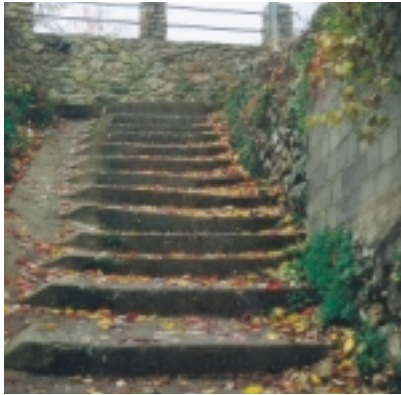
Escalones o peldaños de una escalera.
