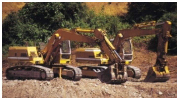
Las excavadoras forman parte de la maquinaria utilizada para la construcción de carreteras.
