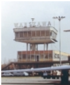
Torre de control de un aeropuerto.
