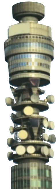
Torre de comunicación dotada de antenas emisoras de ondas electromagnéticas.
