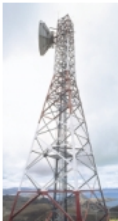
Repetidor de ondas electromagnéticas en una estación de telecomunicaciones boliviana. (Foto BID.)
