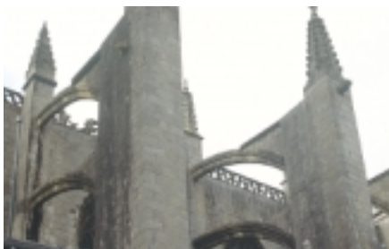
El contrafuerte es un elemento arquitectónico empleado para el reforzamiento de muros.
