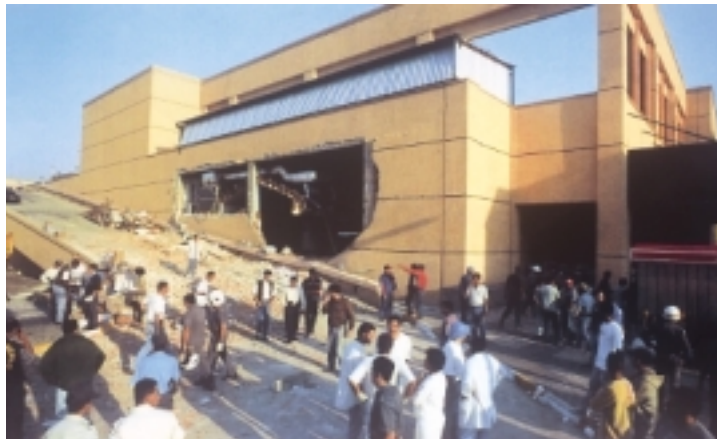
Boquete producido por una explosión de gas en un restaurante brasileño.
