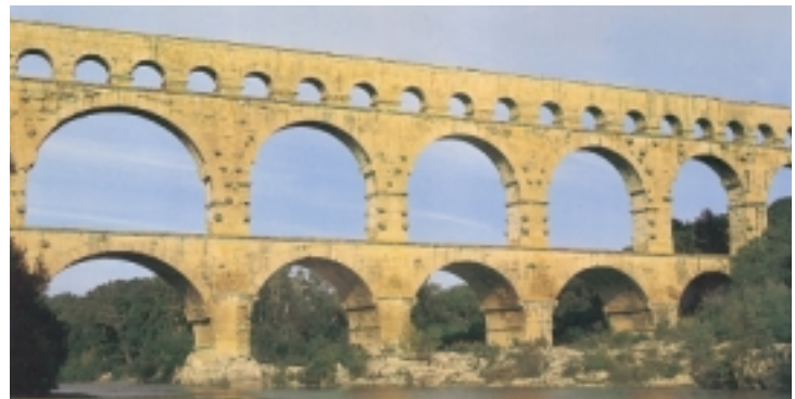
Acueducto romano sobre el río Gard, en la localidad francesa de Vers.
