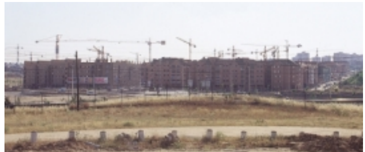
Construcción de edificios en el extrarradio de Madrid.
