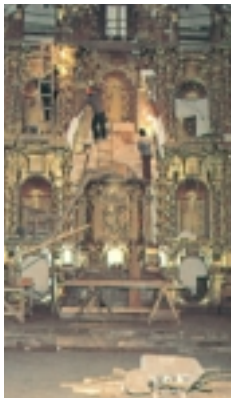
Labores de restauración del altar de una capilla. (Foto BID.)
