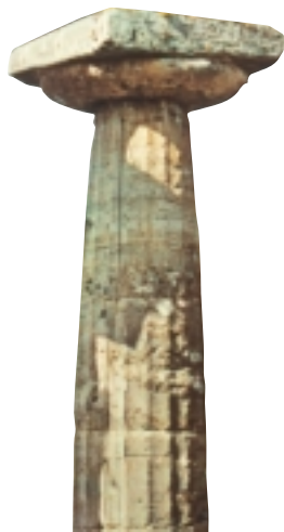
Capitel y parte superior del fuste de una columna de estilo dórico.
