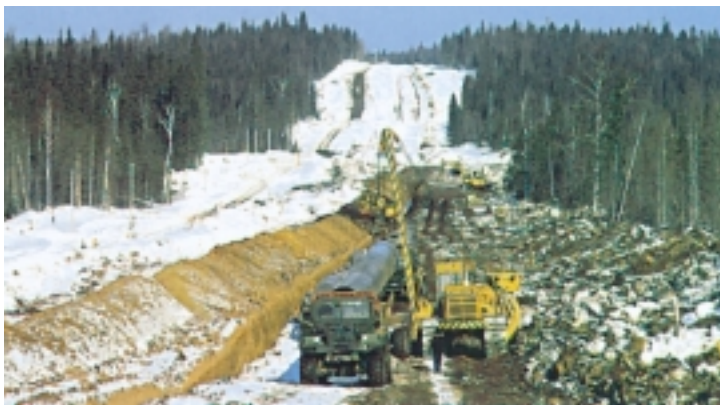
Construcción de un gasoducto en la región de Perm, en Rusia.
