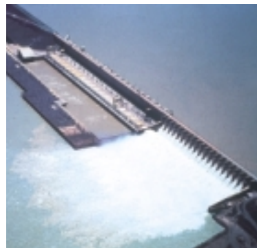
Presa hidroeléctrica de Ilha Soteira, en Brasil. (Foto BID.)
