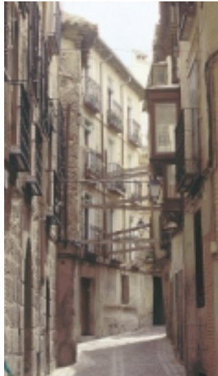
Apuntalar. Fachada apuntalada por unas vigas de hierro.
