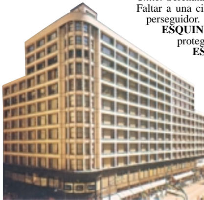
Esquina de un edificio de grandes almacenes en Chicago.
