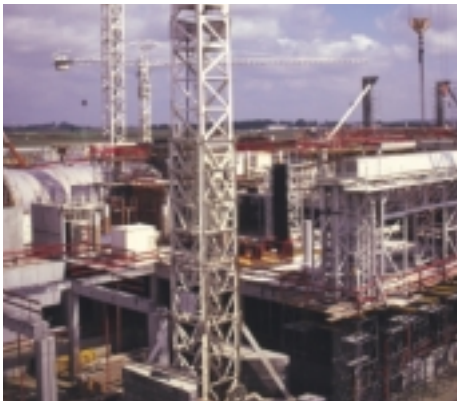
Construcción de edificios.
