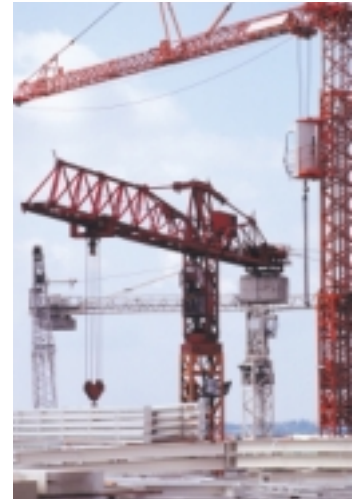
Grúas utilizadas en la obra de un edificio.
