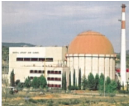
Instalaciones externas de un reactor nuclear.
