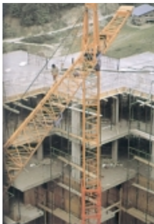
Obra de albañilería.
