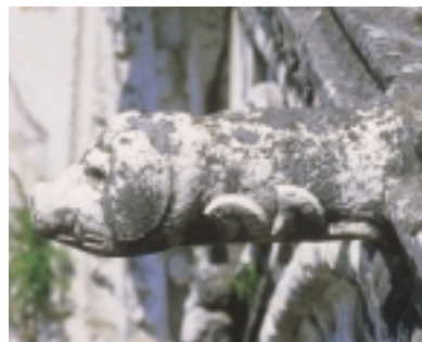
Caño utilizado como desagüe.
