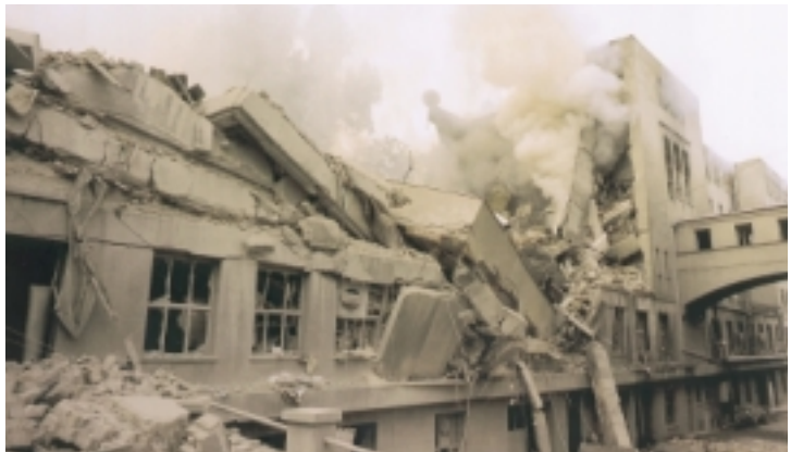
Destrucción del centro de Belgrado.
