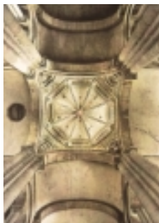
Crucero de la iglesia de Santa Fe, Francia.
