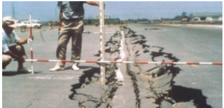
Medición de la profundidad de una grieta producida por un terremoto.
