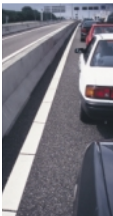
Línea blanca pintada sobre el asfalto para delimitar el ancho de la carretera.
