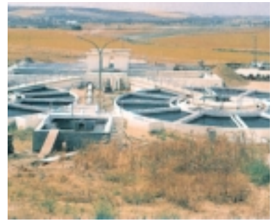
Planta depuradora de aguas destinadas al riego.
