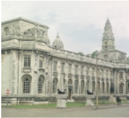
Cardiff. Edificio público en la capital galesa.
