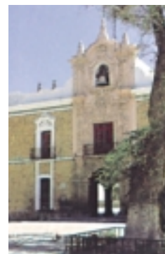
Fachada del Palacio del Gobernador de Tlaxcala.
