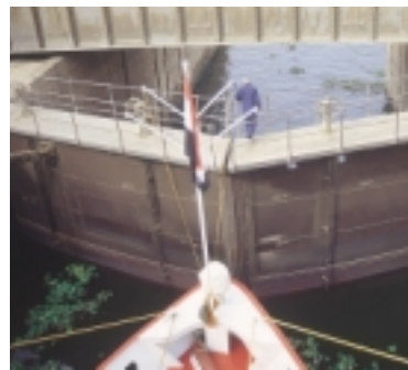
Compuerta de una esclusa.
