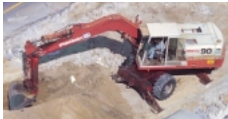
La excavadora forma parte de la maquinaria utilizada para la construcción.
