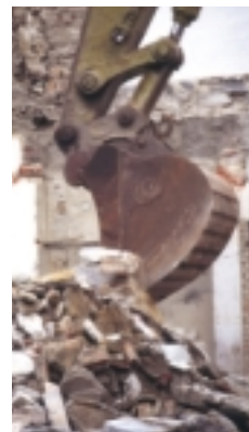
Las palas mecánicas se emplean para remover y cargar escombros y tierra.
